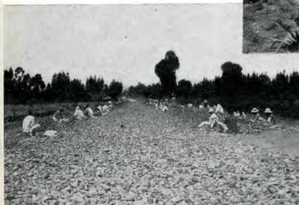
← ? Strade di Addis Abeba in costruzione.
