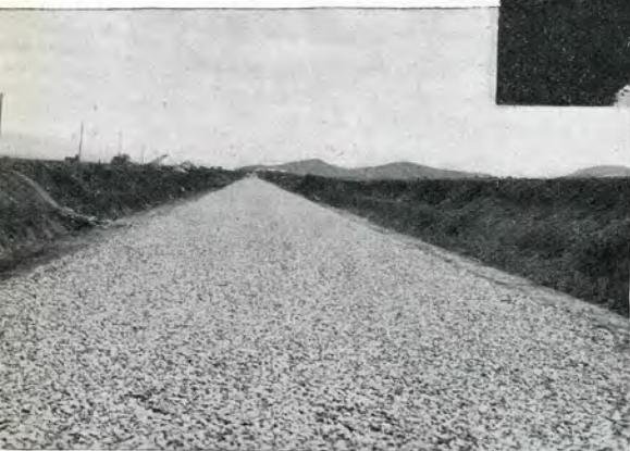
← Strada in costruzione.
