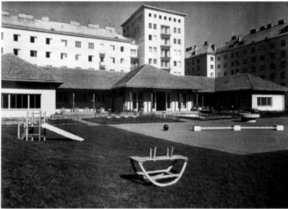
Struttura ricreativa e asilo, Kapuzplatz, Vienna, 1950-52
